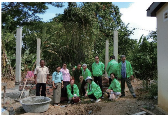
奉仕活動(カンボジア/バタンバン州) 小学校トイレ改修工事支援 会員工事現場視察
